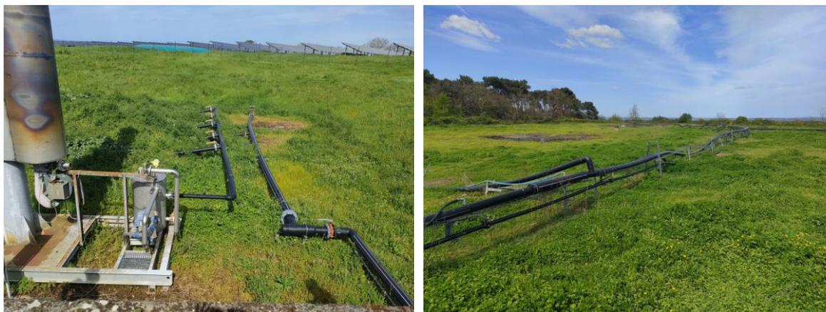
**Figure 32.** Traitement via le filtre biologique d'andains de compost (à gauche) et réseau de collecte du biogaz de la zone 2.
