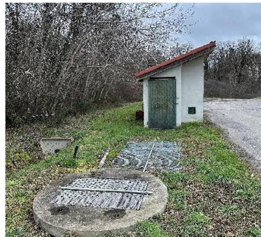
**Figure 22.** Bassin de stockage des lixiviats de la zone 2 (à gauche) et zone technique (local technique, regard de collecte et chambre de vannes) (à droite).
