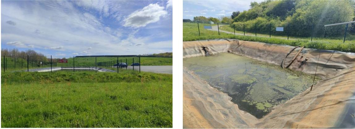
**Figure 4.** Bassin de collecte des lixiviats de la zone 1 (photo de gauche) et de la zone 2 (photo de droite).
