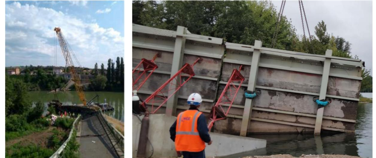
Figure 13 : enlèvement de la foreuse et des éléments de tablier à l'aide d'une grue disposée sur un remblai dans le Tarn
