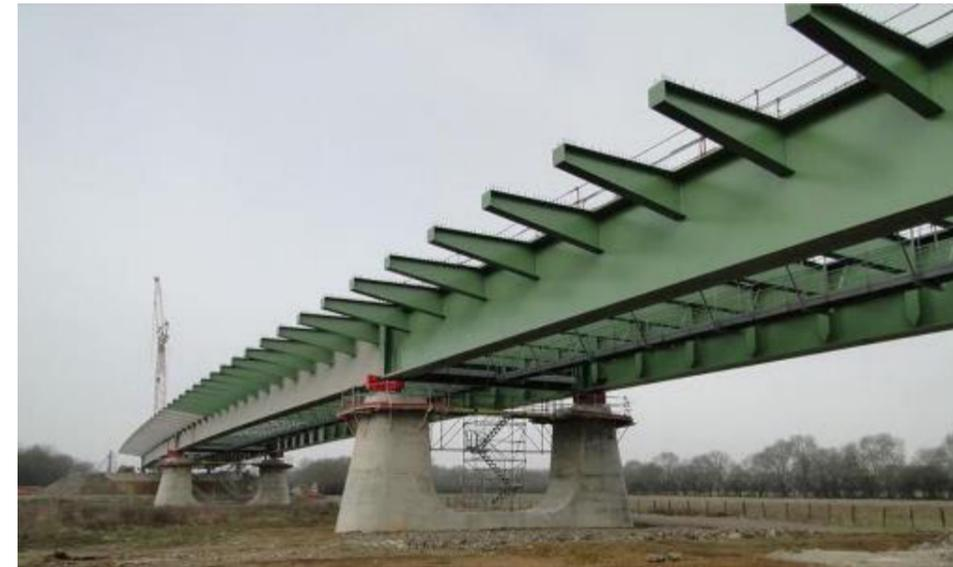
Exemple de charpente bipoutre mixte avec consoles
