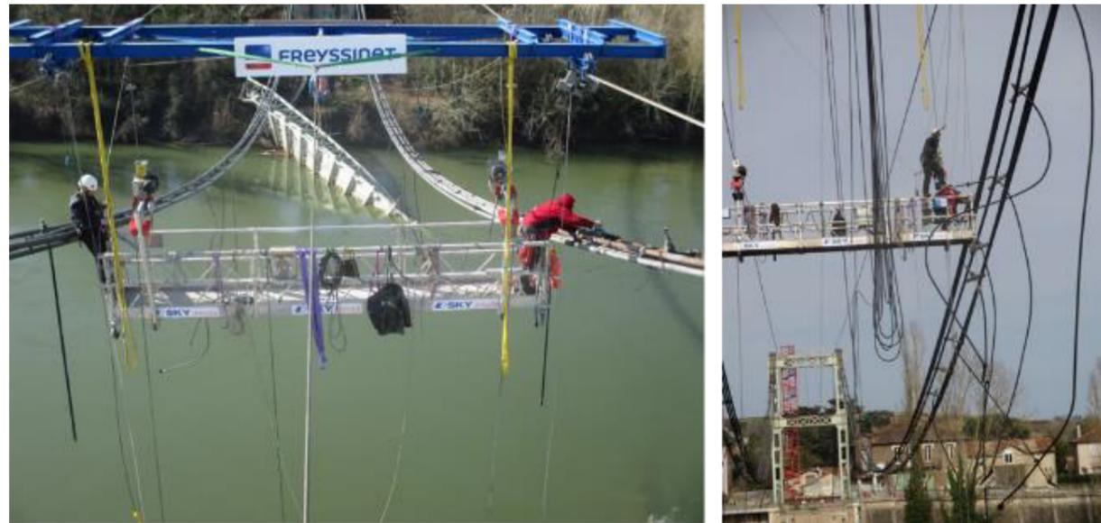
Figure 12 : travaux de dépose des parties aériennes restantes de l'ouvrage existant (câbles, suspentes et pylônes)
