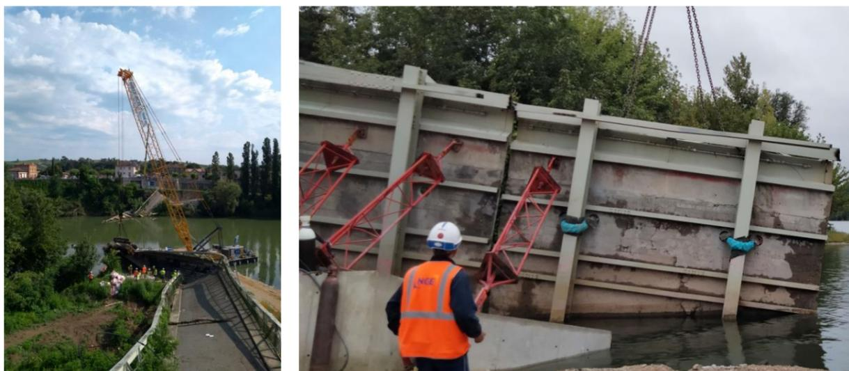
Figure 8 : Enlèvement de la foreuse et des éléments de tablier à l'aide d'une grue disposée sur un remblai dans le Tarn
