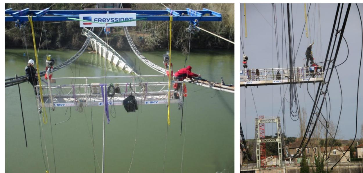
Figure 7 : Travaux de dépose des parties aériennes restantes de l'ouvrage existant (câbles, suspentes et pylônes)
