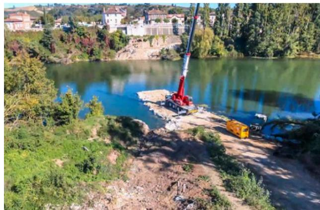
Figure 37 : Remblai réalisé lors du démontage du tablier en 2021
