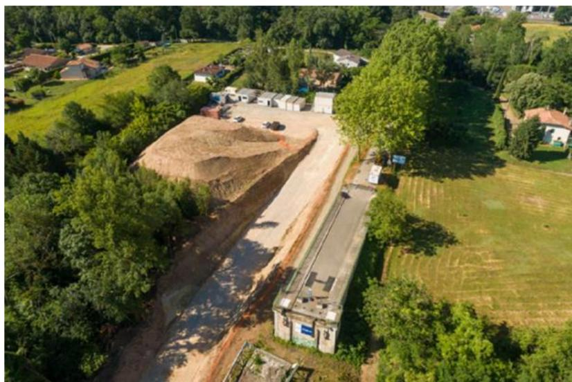
Figure 9 : Rampes d'accès et d'installation de chantier
