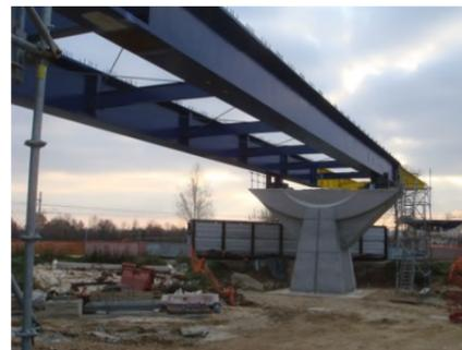
Figure 21 : Exemple de lançage de charpente métallique (Viaduc PI9 déviation de Beauregard à Agen)
