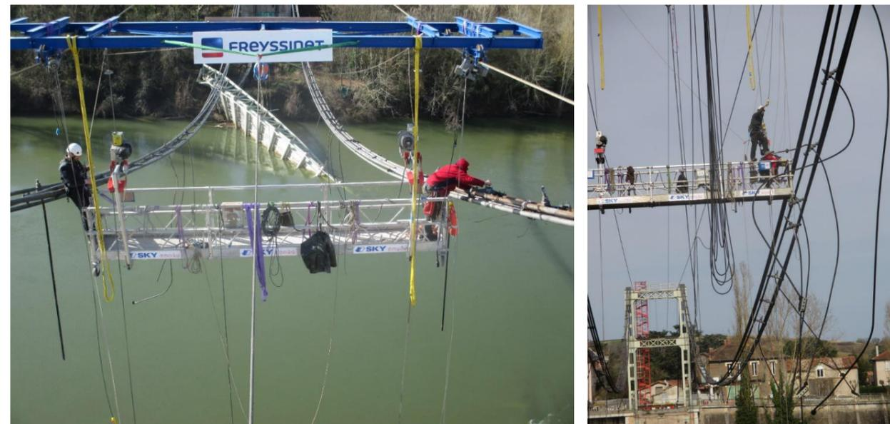
Figure 6 : Travaux de dépose des parties aeriennes restantes de l'ouvrage existant (câbles, suspentes et pylônes)
