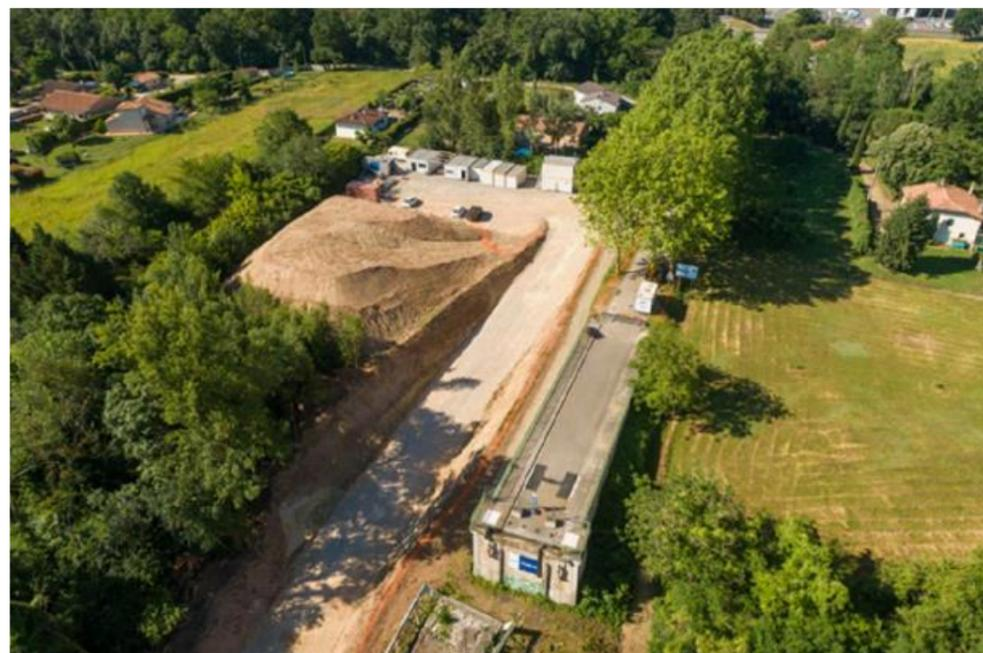
Figure 8 : Rampes d'accès et installation de chantier
