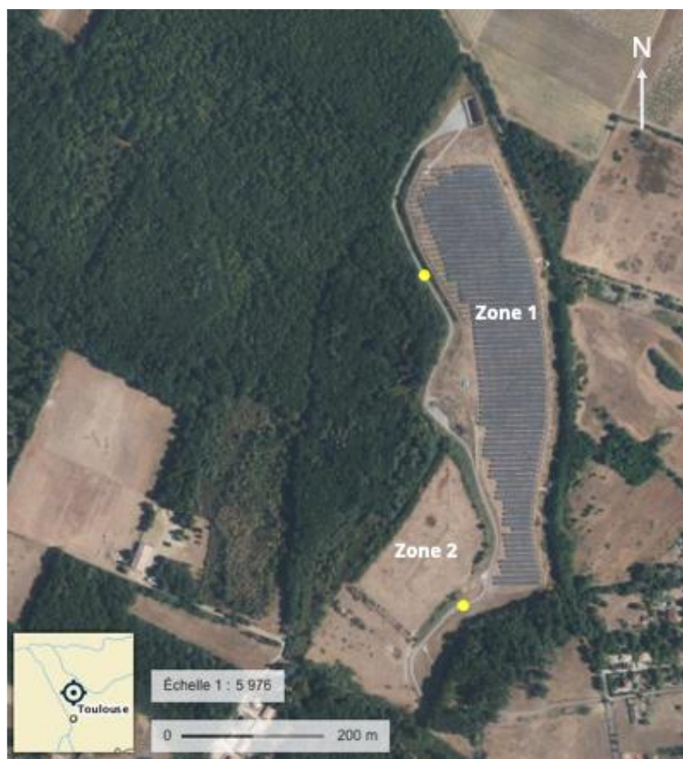
Figure 40. Localisation des deux endroits de voirie se dégradant.
