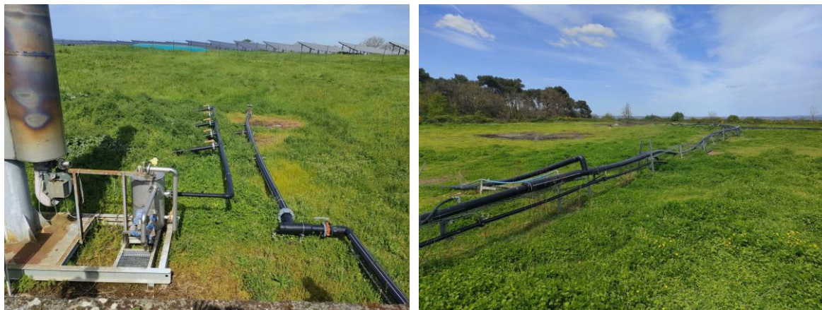
Figure 33. Traitement via le filtre biologique d'andains de compost (à gauche) et réseau de collecte du biogaz de la zone 2.
