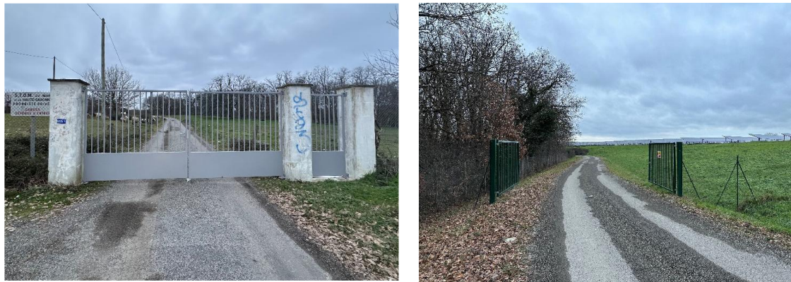
Figure 3. Portail d'accès au CET (à gauche) et portail permettant l'accès au bassin lixiviats de la zone 1 (à droite).
