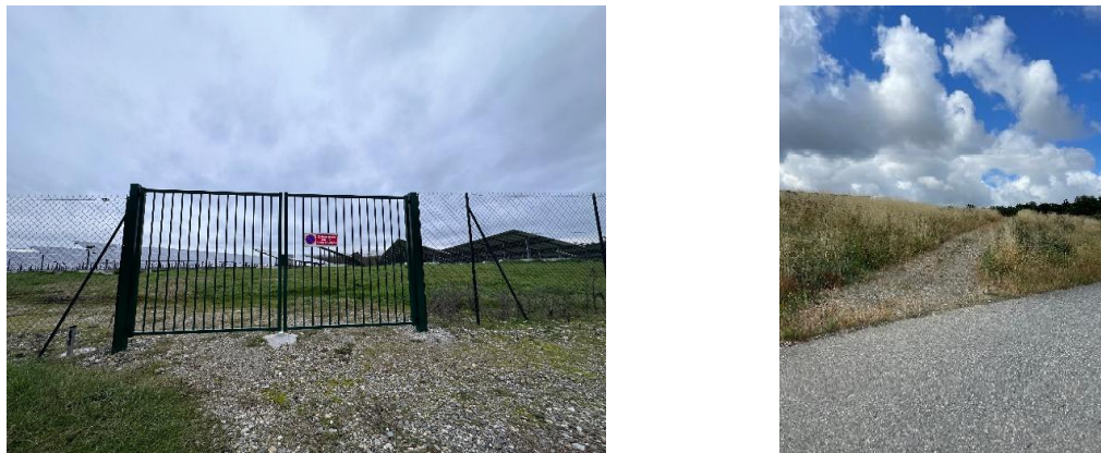
Figure 5. Accès au parc photovoltaïque en amont du bassin n°2 (photo de gauche) et en aval de la zone 1 (photo de droite).
