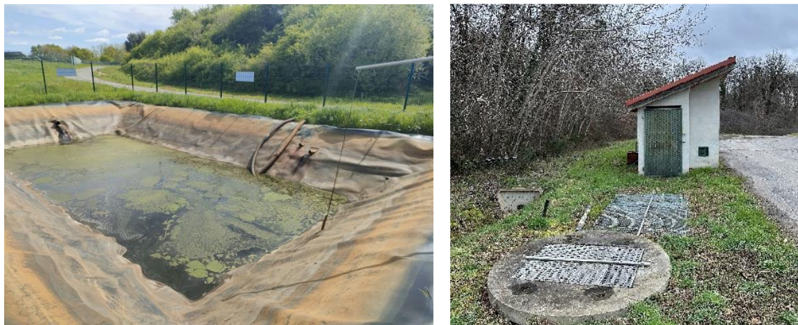
Figure 22. Bassin de stockage des lixiviats de la zone 2 (à gauche) et zone technique (local technique, regard de collecte et chambre de vannes) (à droite).
