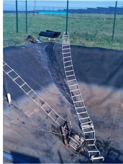
Figure 39. Photographie de la déchirure (avant réparation par l'entreprise GETECH sur la photo de gauche) présente au niveau du bassin de lixiviats de la zone n°2 et une fois réparée sur la photo de droite.
