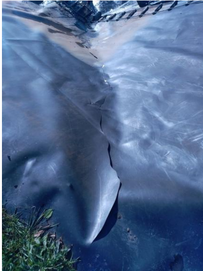
Figure 39. Photographie de la déchirure (avant réparation par l'entreprise GETECH sur la photo de gauche) présente au niveau du bassin de lixiviats de la zone n°2 et une fois réparée sur la photo de droite.
